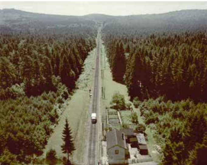
Bitche (Moselle) : voie ferrée, d'après négatif couleur chromogène. Arch. nat, 1PH/802.
