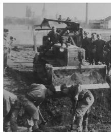
*Remblaiement d'un fossé anti-char à l'aide d'un bulldozer.*
