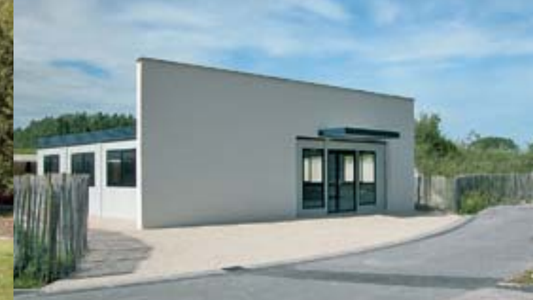
Bâtiment de restauration à disposition des scolaires
