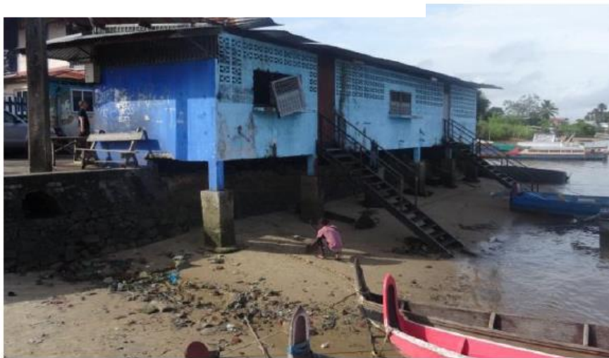
Infrastructure communale fermée depuis 2014. Saint-Laurent-du-Maroni. © Liova Romeo
