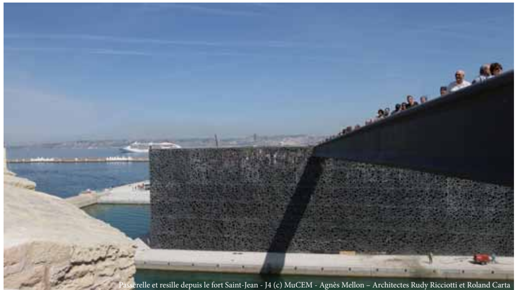
Passerelle et resille depuis le fort Saint-Jean - J4 (c) MuCEM - Agnès Mellon - Architectes Rudy Ricciotti et Roland Carta
