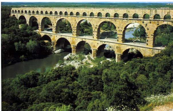
Cet aqueduc mesurant 49 km amenait à Nîmes des eaux de source captées près d'Uzès. Le canal traversait la vallée du Gard sur un pont de 48 m de haut.
