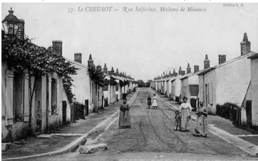
Source : écomusée du Creusot-Montceau les mines
