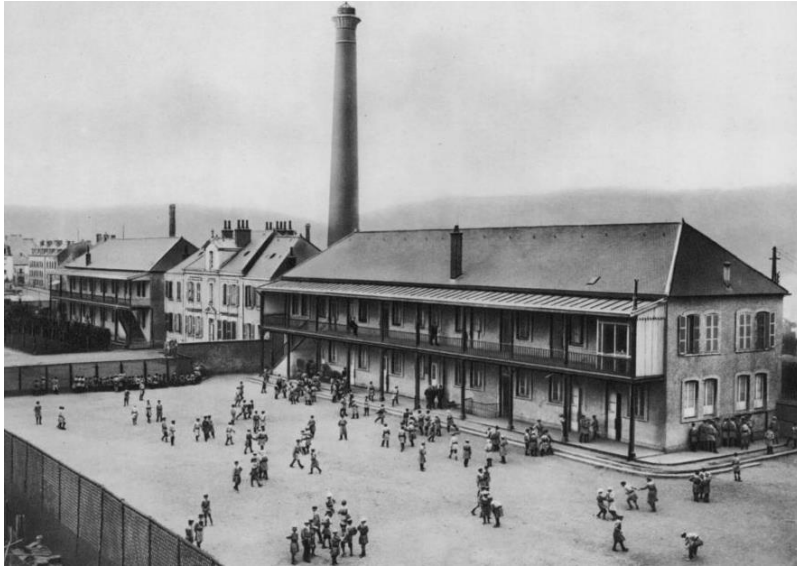
Source : écomusée du Creusot-Montceau les mines
